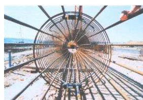
Armatures d'un pieu géothermique
